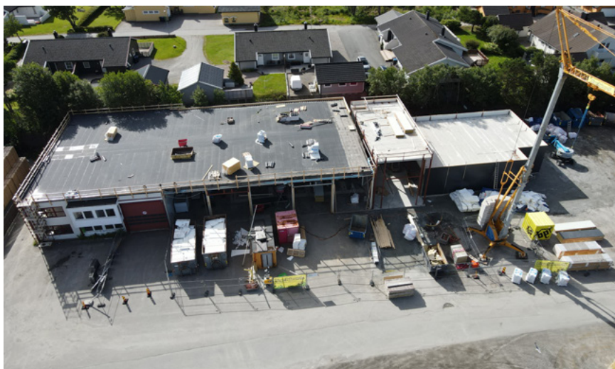
Ny brannstasjon på Rørvik under bygging
